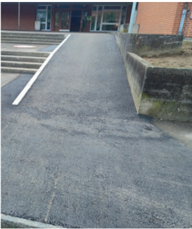
Die Treppe zur Mehrzweckhalle wurde in Verlauf der Arbeiten teilweise zu einer nützlichen Rampe umgestaltet.
